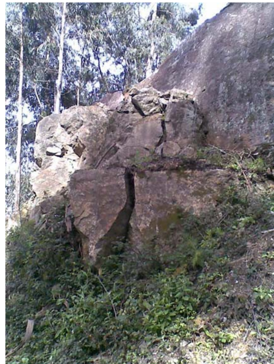
Detalle de conjunto fragmentos rocosos que deben ser saneados
