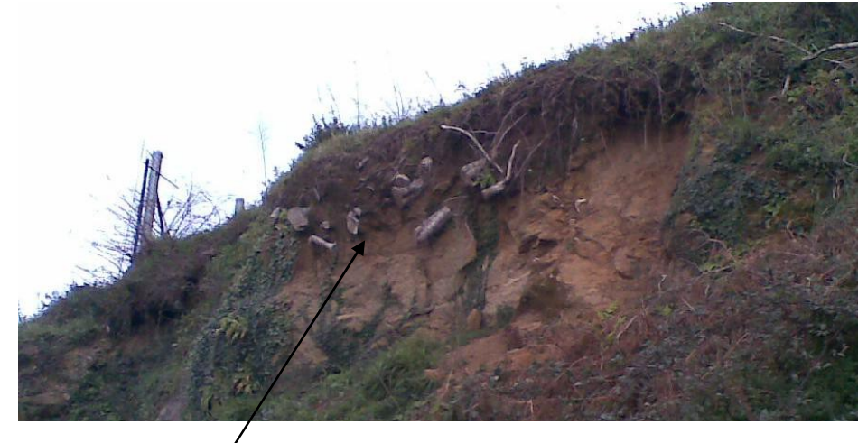
Detalle de las gruesas raíces existente en la montera
